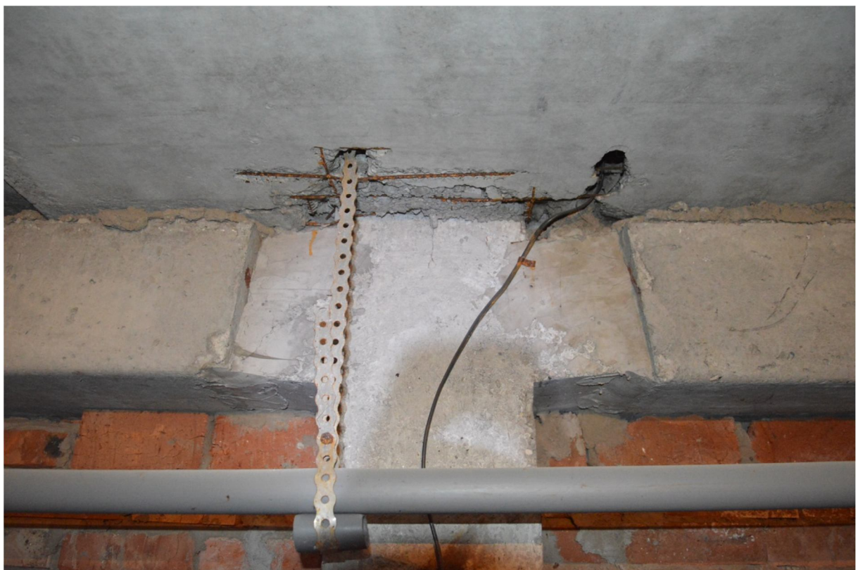
Фото Д.15, Д.16 Общие виды узлов сопряжения колонн и ригелей
