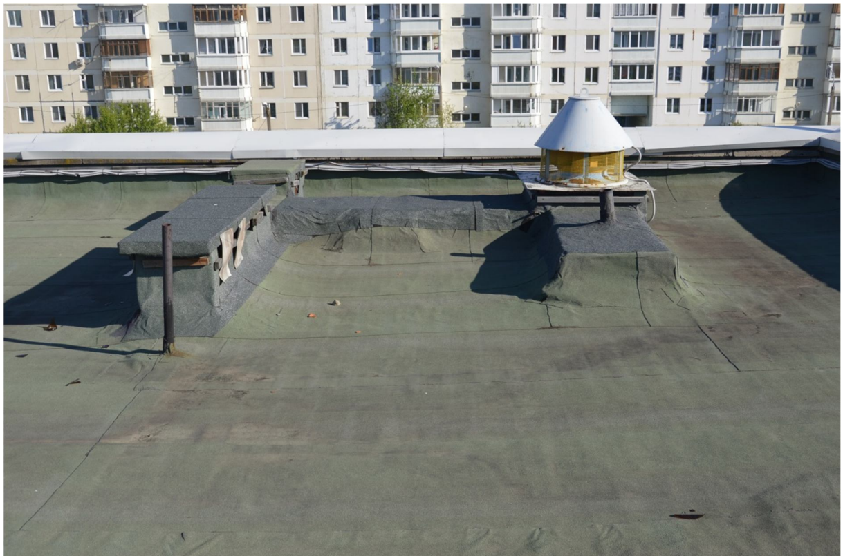
Фото Д.13, Д.14 Общие виды кровли здания
