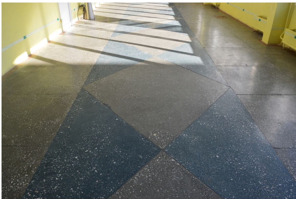
Фото Д.12 Общий вид коридора здания
