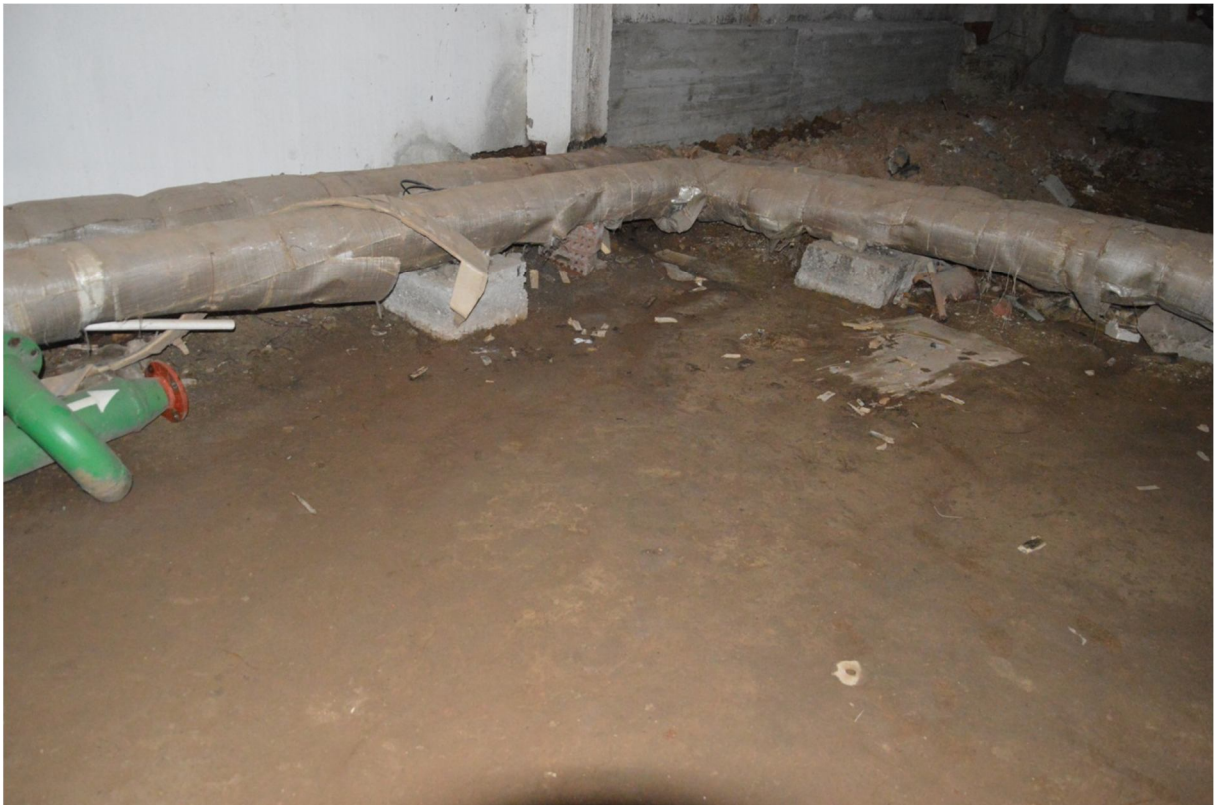
Фото Д.17, Д.18 Общие виды тех. подполья здания
